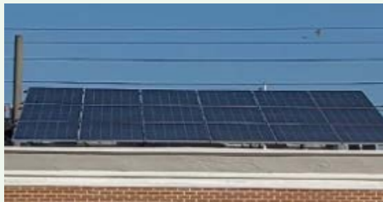
蕪湖先聲 配電房屋頂安裝光伏發電設施
